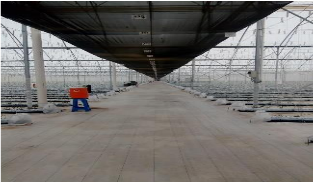
Figura 38. Pasillo de Invernadero 1 sin Áreas Marcadas
