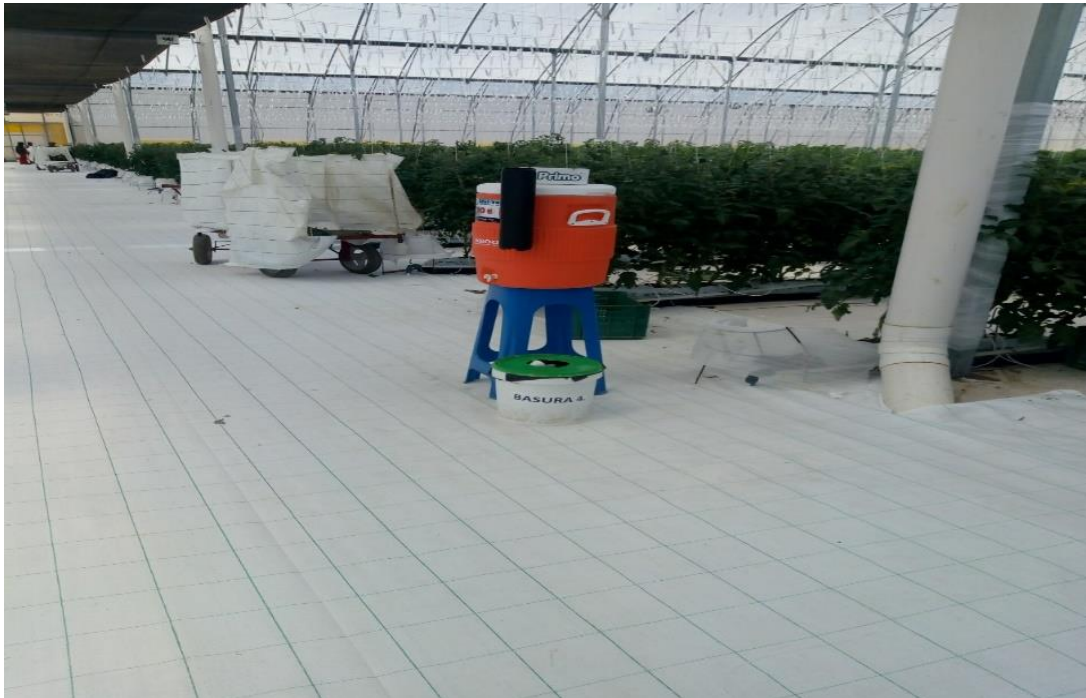
Figura 39. Pasillo de Invernadero 2 sin Áreas Marcadas
