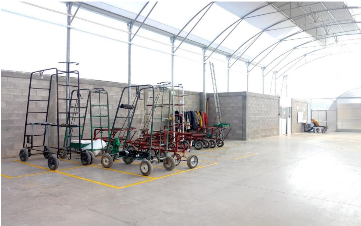
Figura 48. Pasillo de comunicación con Áreas Marcadas Para Carrocería
